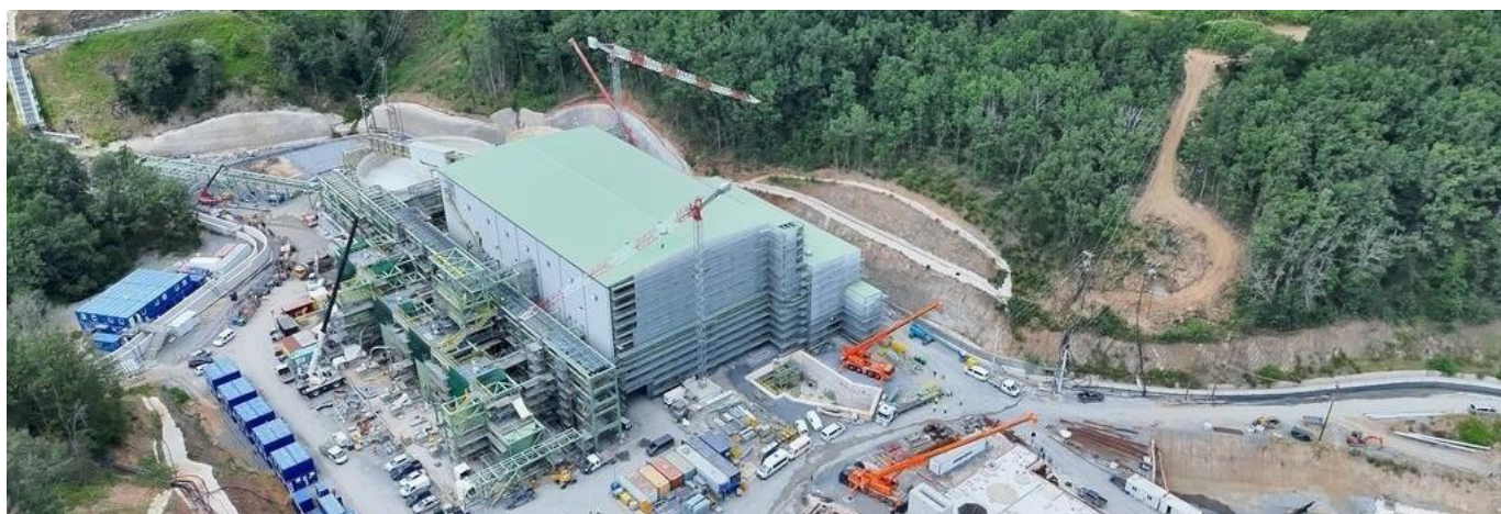
Εγκατάσταση φιλτραρισμένων καταλοίπων
