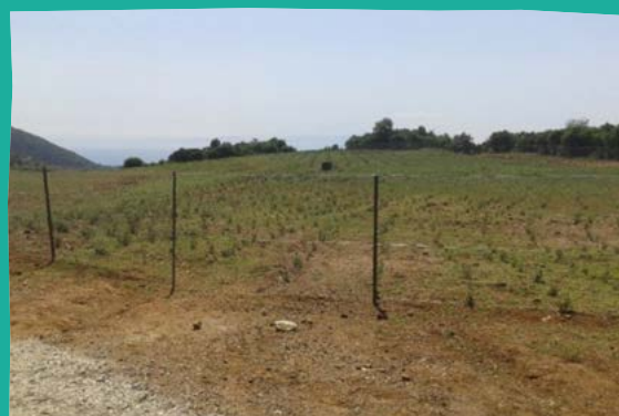
(β) Πρώτη φάση αποκατάστασης
