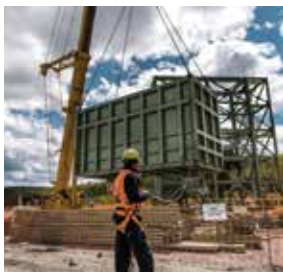
Κατασκευαστικές εργασίες στις Σκουριές.
