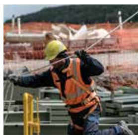
Κατασκευαστικές εργασίες στις Σκουριές.
