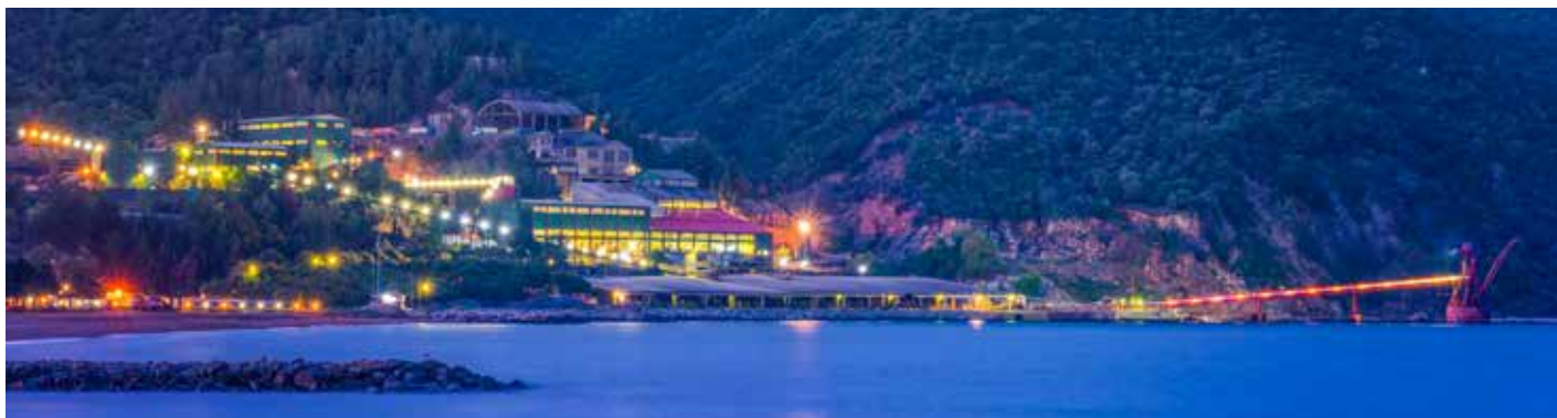
Λιμενικές Εγκαταστάσεις Στρατωνίου.
