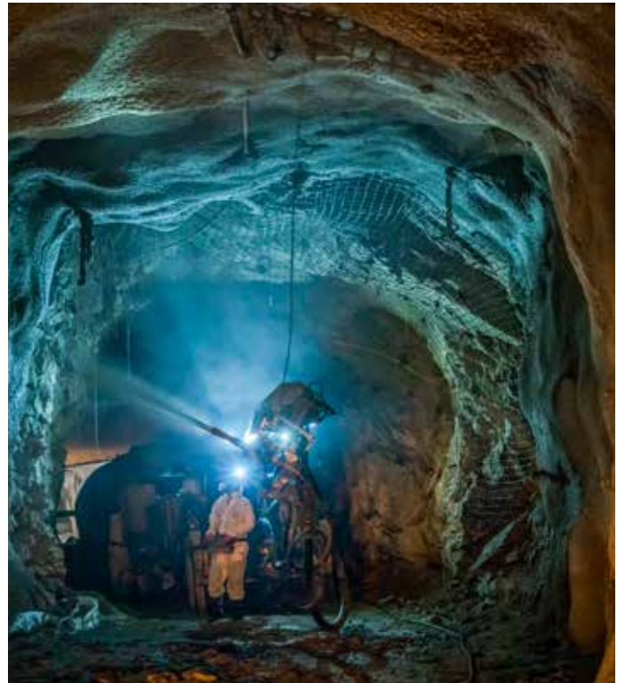
Λιθογόμωση Υπογείων Στοών Ολυμπιάδας.
