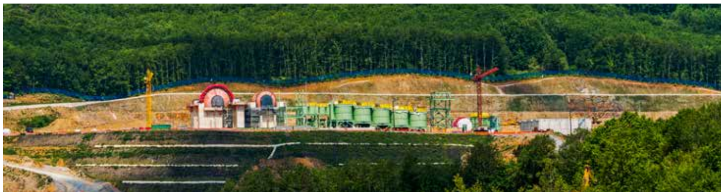
Κατασκευή Εργοστασίου Σκουριών.
