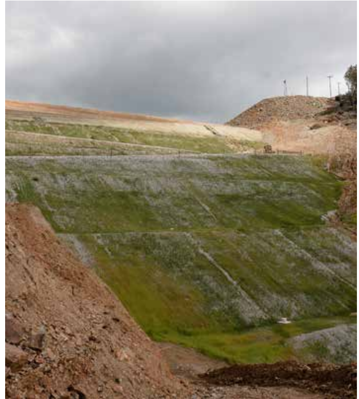
Υδροσπορά στην περιοχή του φράγματος Κοκκινόλακα.
