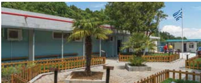
Γραφεία του μεταλλευτικού έργου Ολυμπιάδας.
